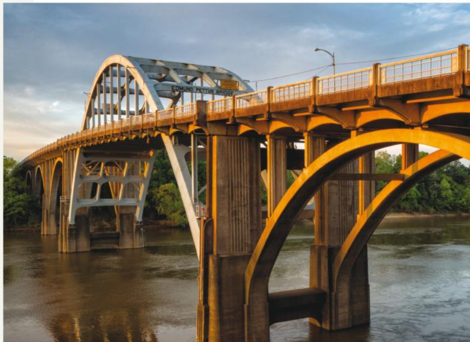
▲ Edmund Pettus Bridge, Selma, AL
